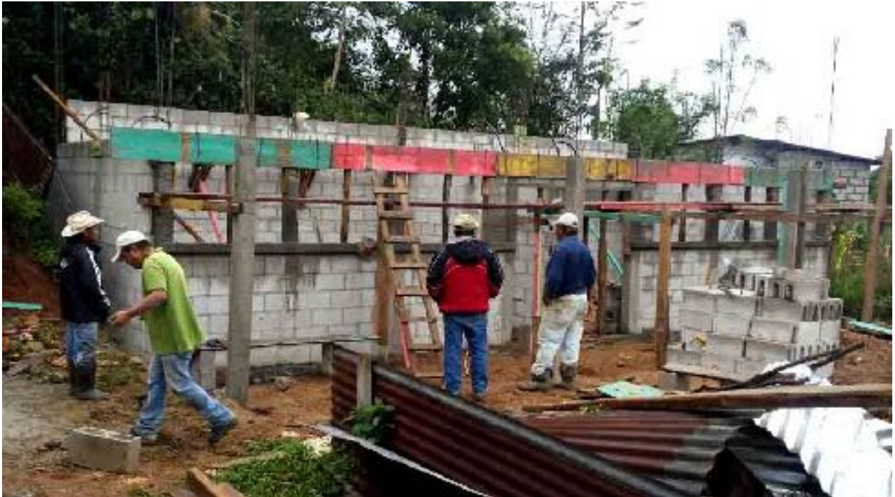
Das neue Schulgebäude in Capucalito - gebaut aus Spendengeldern.
