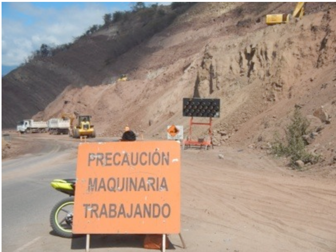
Vollsperrung: Autobahnbaustelle am Hang der Vulkane
