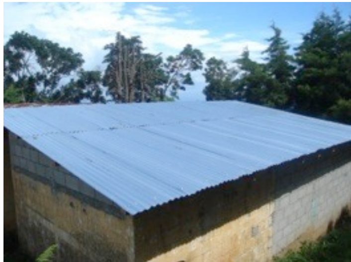
Das neue Wellblech liegt bereits auf den Dachsparren
