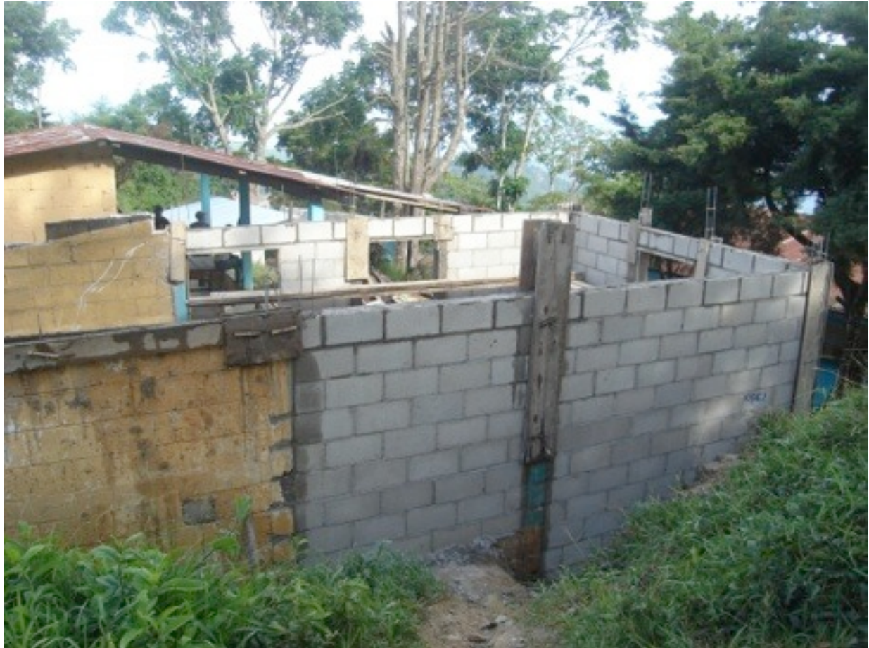
Der Neubau der Schulküche am 15. Juli 2015. Jetzt fehlt noch das Dach, der Putz und die Fenster.
